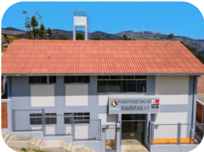
13. Puesto de Salud I-1, Rambrampata
