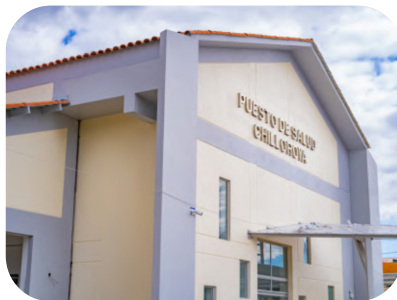
8. Puesto de salud I-1, Chillroya
